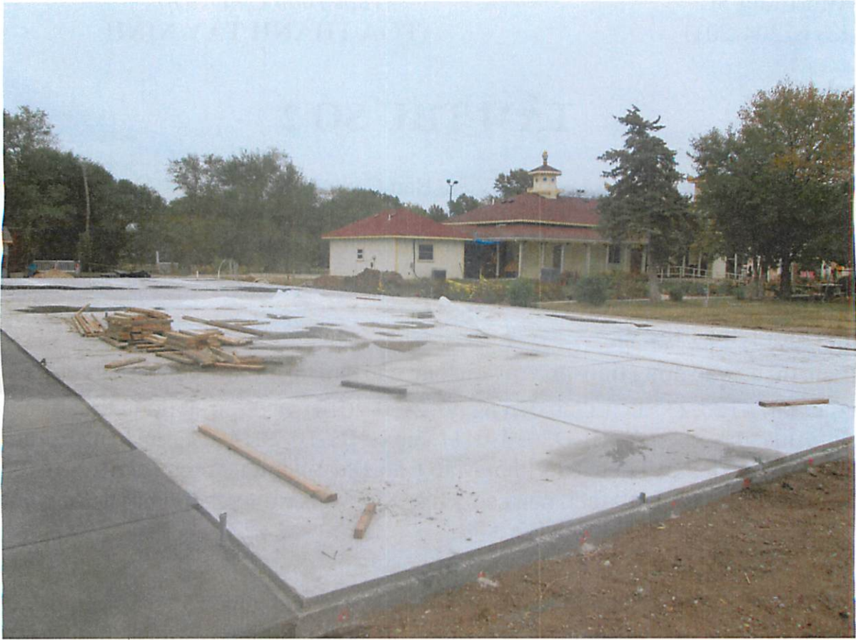
Nền móng Hội trường mới đổ bê tông 120 Feet dài, 40 feet rộng
