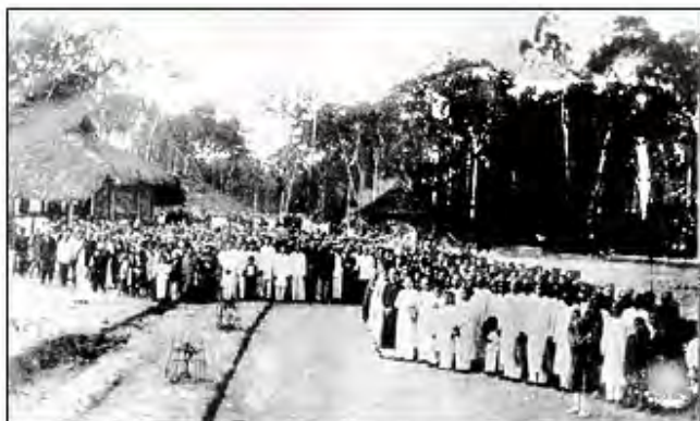
LỄ KHỞI CÔNG XÂY CÁT TÒA THÁNH
